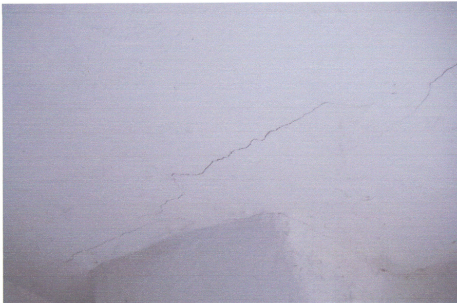
– Gryfice, ul. Orzeszkowej 3 – dobudowany fragment oficyny piętro obiektu (widoczne zarysowania stropu i ścian)
