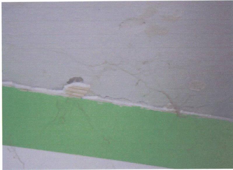
– Gryfice, ul. Orzeszkowej 3 – dobudowany fragment oficyny piętro obiektu (widoczne zarysowania stropu i ścian)
