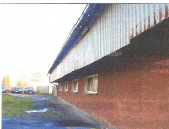
ściana frontowa budynku po kotłowni
