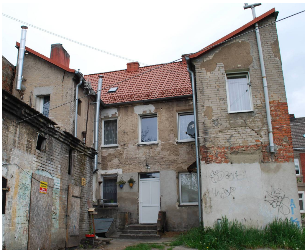
Gryfice ul. Armii Krajowej 15 - elewacja południowo-wschodnia
