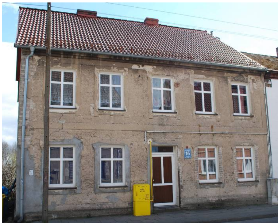
Gryfice ul. Armii Krajowej 15 - elewacja frontowa północno-zachodnia
