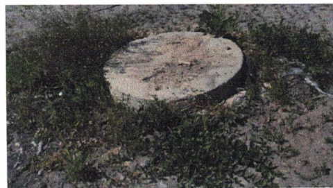
studzienka kanalizacji ściekowej dz. 21/36 -
