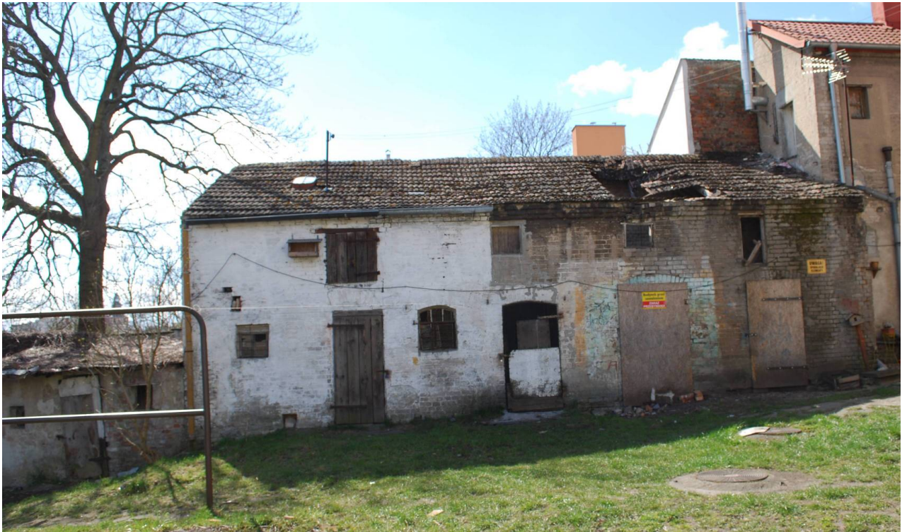
Gryfice, dz. nr 50/33 – rozbiórka budynku gospodarczego - elewacja północno-wschodnia
