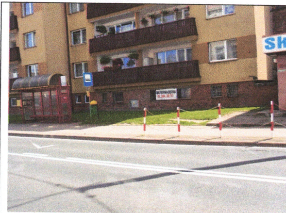
ul. Kościuszki 11. W kondygnacji podpiwniczenia tabliczka z ofertą dzierżawy kotłowni CO, która usytuowana w tej części budynku
