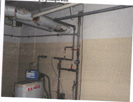
• pomieszczenie po pompowni
