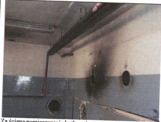
Za ścianą pomieszczenie kotłowni
