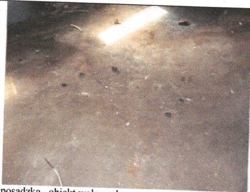
posadzka – obiekt wolny od rzeczy
