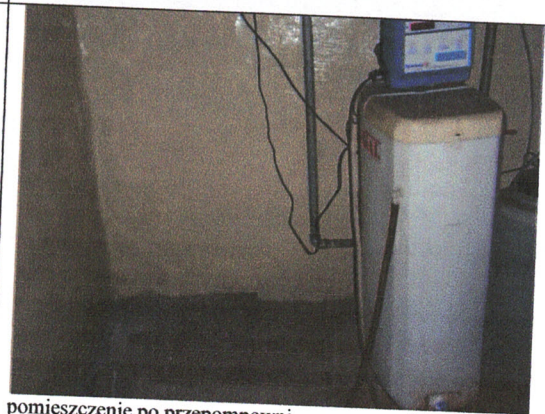
pomieszczenie po przepompowni
