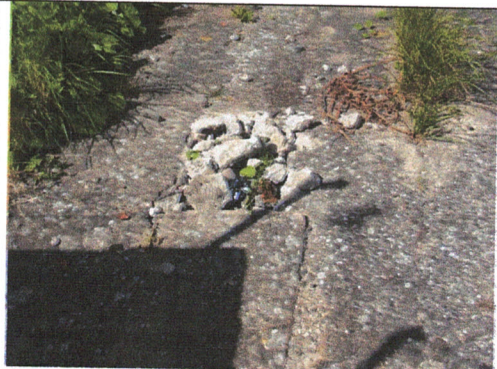
Utwardzono w przeszłości teren poza budynkiem do obsługi kotłowni CO
