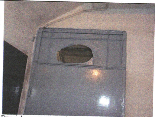
Drzwi do przepompowni z korytarza ogólnego podpiwniczenia
