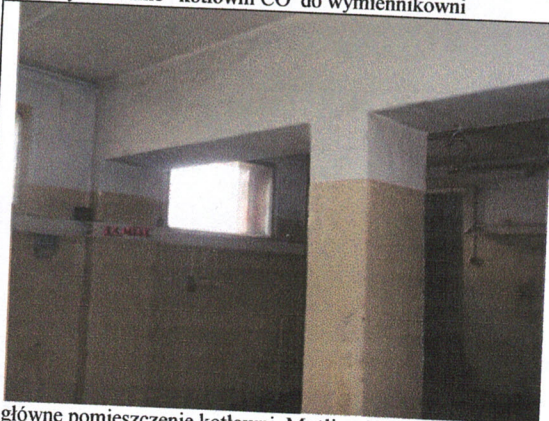
główne pomieszczenie kotłowni. Możliwość utworzenia dwóch pomieszczeń
