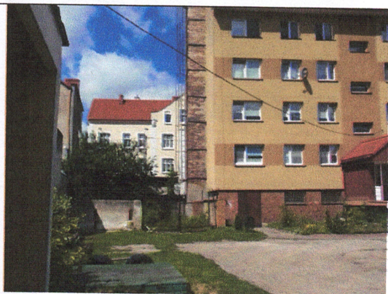
Teren zajęty na obsługę byłej kotłowni CO z lewej strony – odgrodzony i znajduje się na innym obszarze działki – czyli 33/11.
