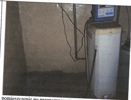
pomieszczenie po przepompowni
