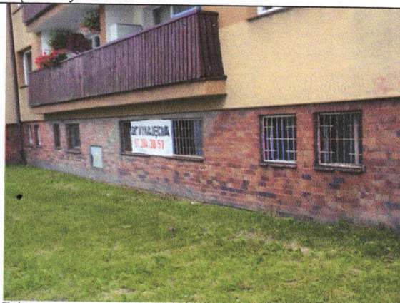
Zakratowane okna kotłowni CO.
