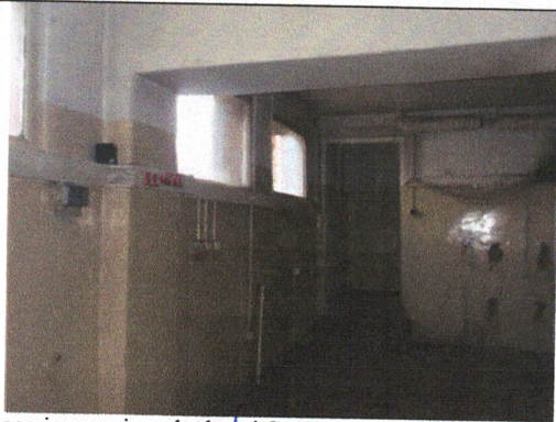
pomieszczenie po kotłowni Co. W głębi schodki do części socjalnej. Okna okratowane z widokiem na ulicę T. Kościuszki.
