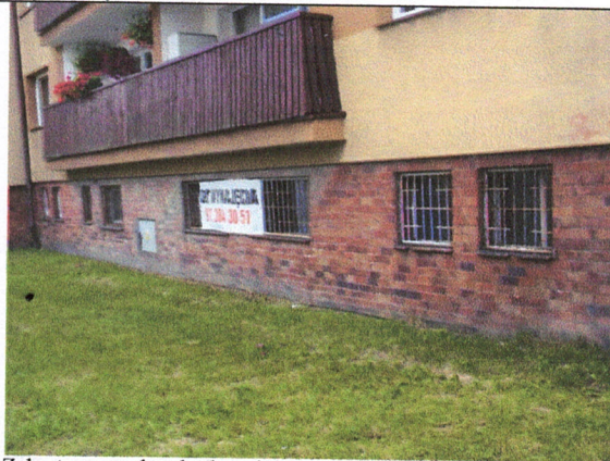
Zakratowane okna kotłowni CO.
