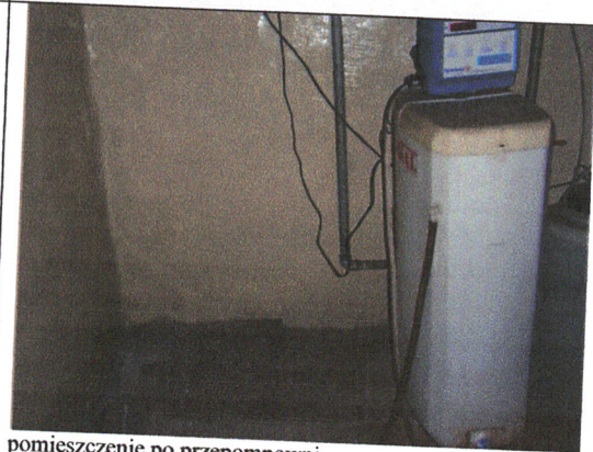
pomieszczenie po przepompowni
