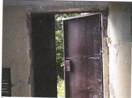
Drzwi wejściowe do pomieszczeń po kotłowni CO
