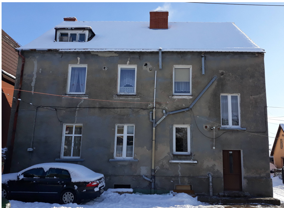
- Gryfice, ul. Rapackiego 23 elewacja zachodnia
