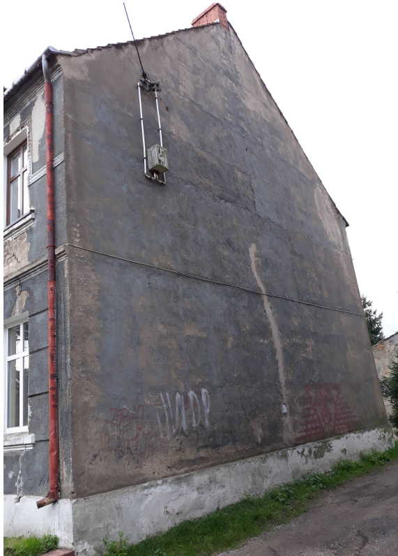
- Gryfice, ul. Rapackiego 23 elewacja północna
