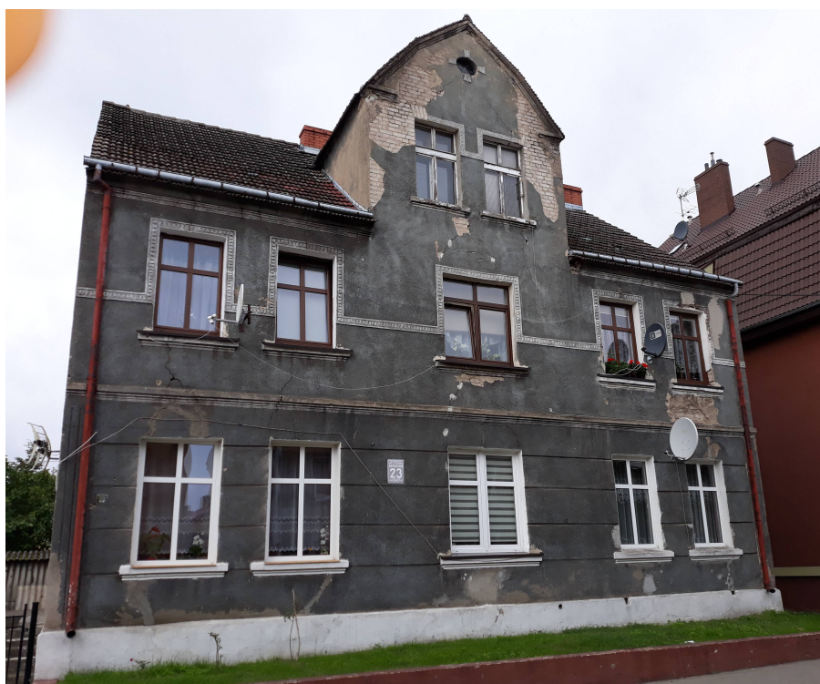
- Gryfice, ul. Rapackiego 23 elewacja wschodnia
