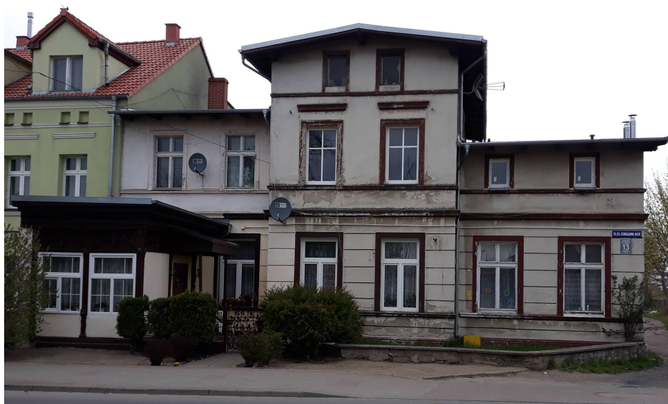
Gryfice, ul. Ks. Stanisława Ruta 13 - elewacja południowa
