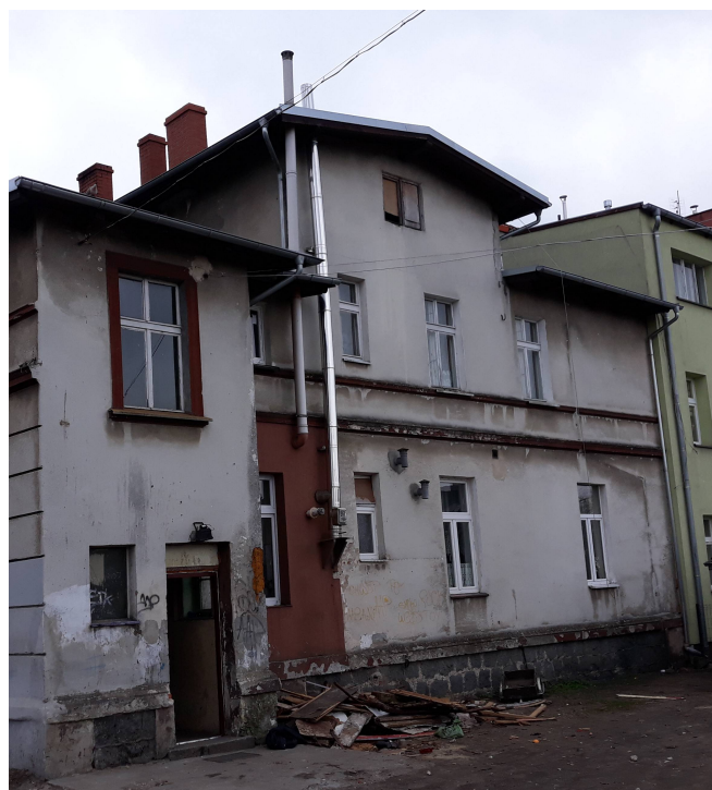
Gryfice, ul. Ks. Stanisława Ruta 13 - elewacja północna
