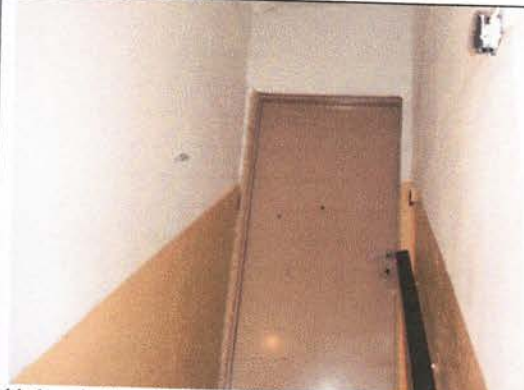
klatka schodowa *B*. W głębi-drzwi zwyczajowo zamknięte
