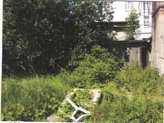
w głębi metalowe drzwi wejściowe do pomieszczeń po kotłowni CO. Wejście należy do dz. 33/11 Widać także kawałek kominu.
