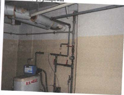
• pomieszczenie po pompowni
