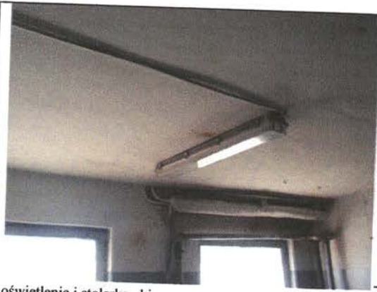
oświetlenie i stolarka okienna
