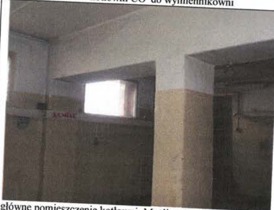
główne pomieszczenie kotłowni. Możliwość utworzenia dwóch pomieszczeń
