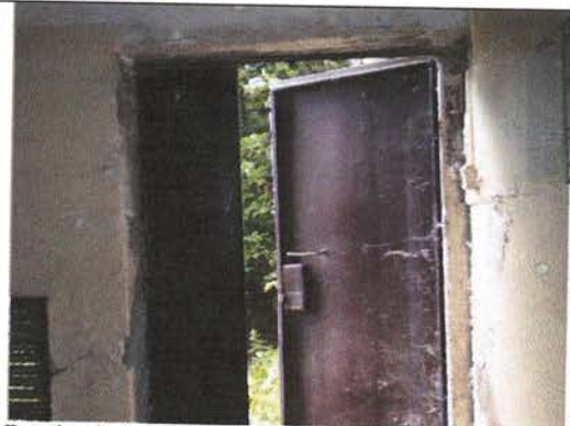
Drzwi wejściowe do pomieszczeń po kotłowni CO
