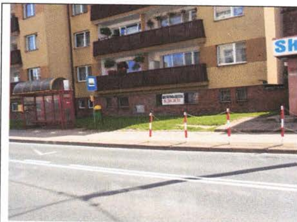
ul. Kościuszki 11. W kondygnacji podpiwniczenia tabliczka z ofertą dzierżawy kotłowni CO, która usytuowana w tej części budynku
