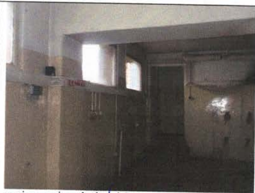
pomieszczenie po kotłowni Co. W głębi schodki do części socjalnej. Okna okratowane z widokiem na ulicę T. Kościuszki.
