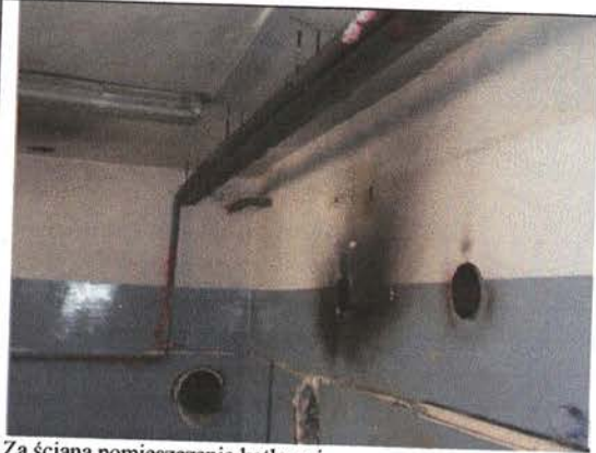
Za ścianą pomieszczenie kotłowni
