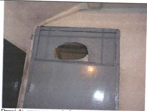
Drzwi do przepompowni z korytarza ogólnego podpiwniczenia
