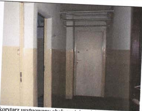
korytarz usytuowany obok części socjalnej i pompowni wiodący do korytarza ogólnego podpiwniczenia tego budynku.
