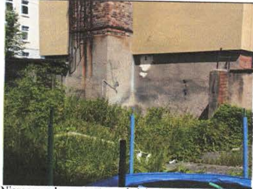
Niezagospodarowany teren obok kotłowni CO
