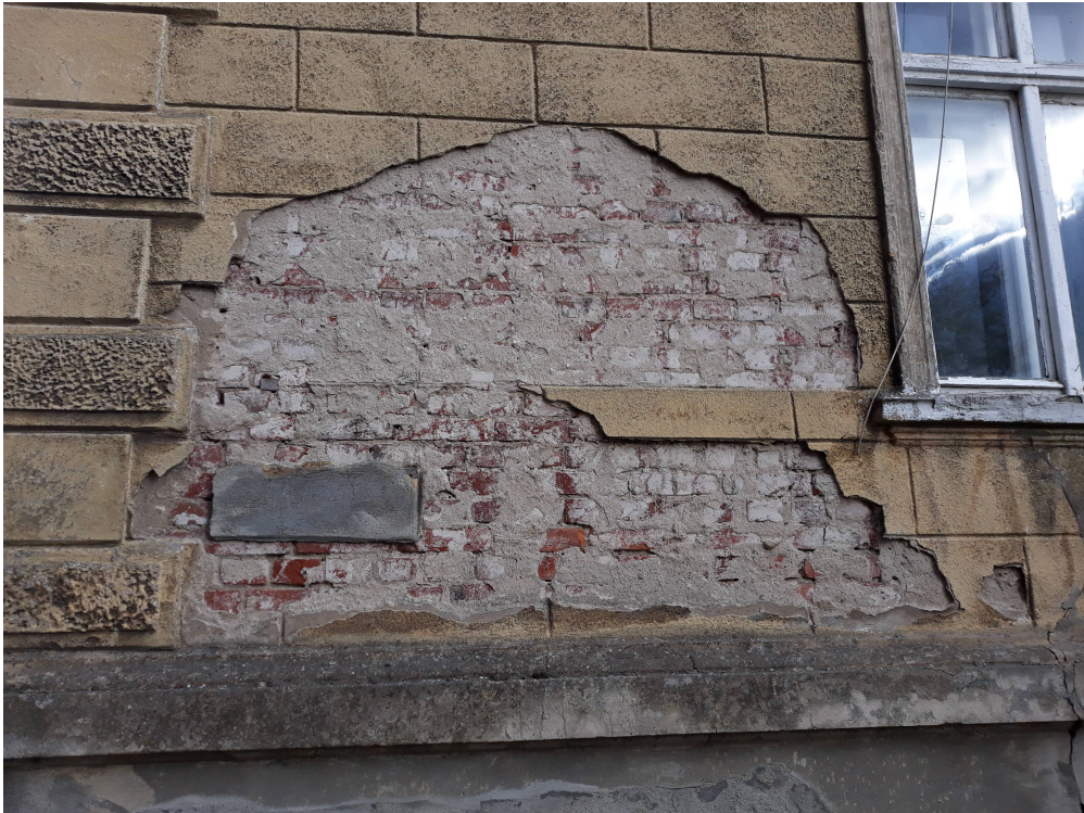
Gryfice, ul. Wysoka Brama 1 – ubytki tynków zewnętrznych
