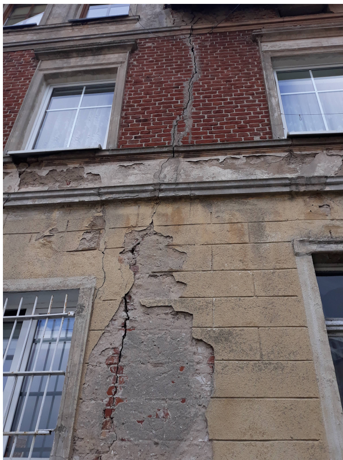
Gryfice, ul. Wysoka Brama 1 – ubytki tynków zewnętrznych, spękania ścian zewnętrznych
