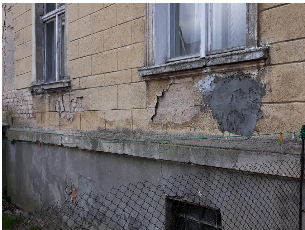
Gryfice, ul. Wysoka Brama 1 – liczne ubytki tynków zewnętrznych
