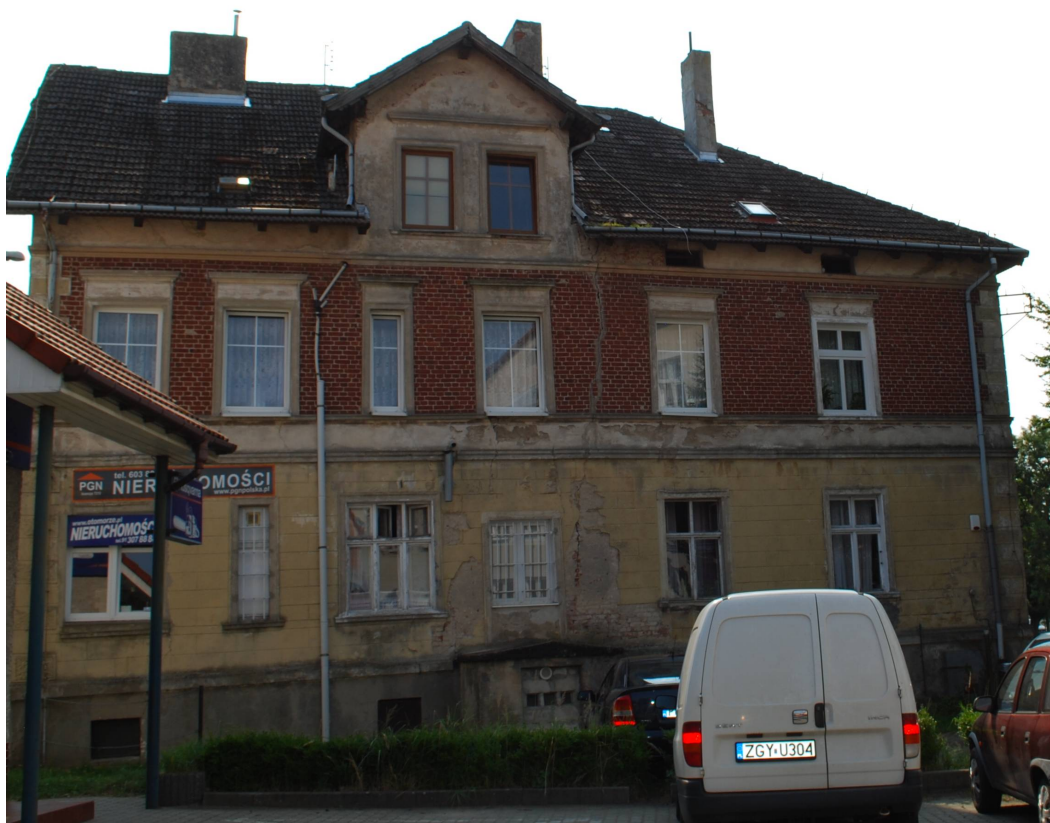
Gryfice, ul. Wysoka Brama 1 -elewacja północno-zachodnia
