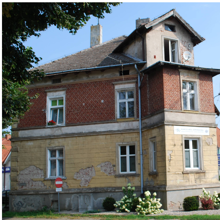
Gryfice, ul. Wysoka Brama 1 -elewacja południowo-zachodnia
