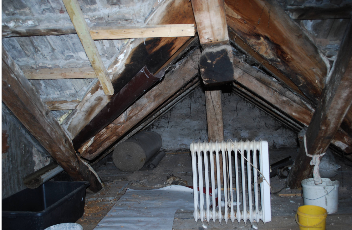
Gryfice, ul. Wysoka Brama 1 – wielbłąd dachowa – widok na spróchniałe krokwie koszowe i płatew kalenicową
