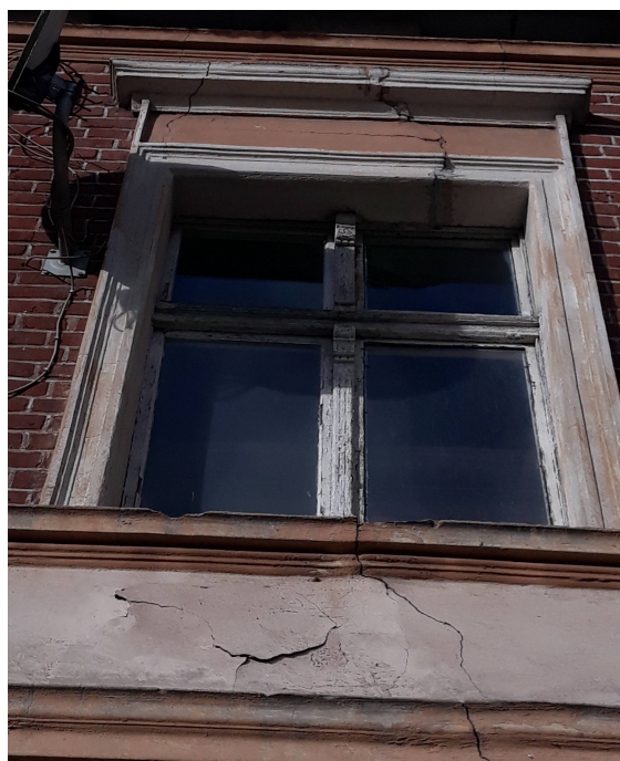
Gryfice, ul. Wysoka Brama 1 – odspojenie tynków zewnętrznych, spękania ścian zewnętrznych
