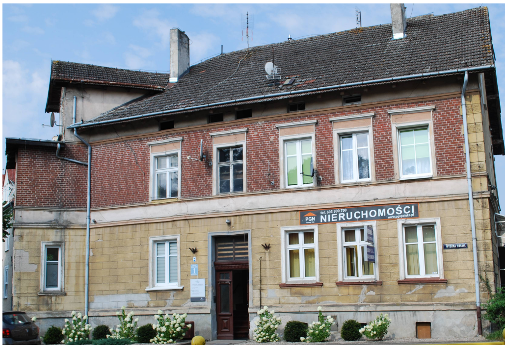
Gryfice, ul. Wysoka Brama 1 -elewacja południowo-wschodnia
