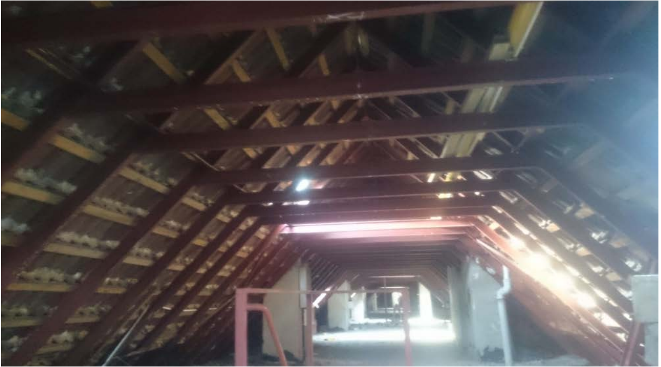
Gryfice ul. Armii Krajowej 39 – stalowa konstrukcja dachu
