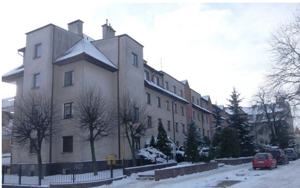
Gryfice ul. Armii Krajowej 39 – elewacja północno-zachodnia i wschodnia
